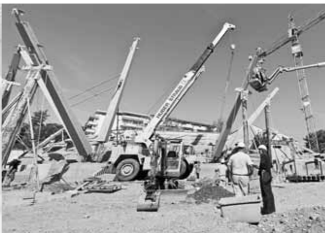
Verwaltungsratspräsidentin Elisabeth Simonius begrüsst die Gönner-abonnentinnen und -abonnenten am Gönner-Anlass im Affenhaus. Die berühmte Gorilladame «Goma» bei der Ankunft im umgebauten Affenhaus. Die Pfeiler für die Menschenaffen-Aussenanlagen werden gestellt.
